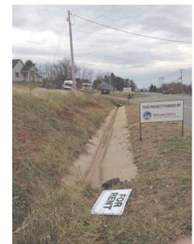
Photo of Site Discharge Swale (n.t.s.)
